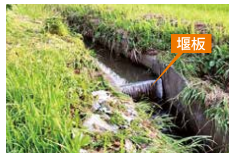
▲堰板が設置してある排水路
