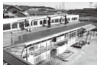
ようりん保育園の雨漏り修繕工事
