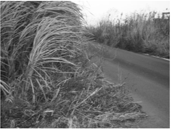
草が生い茂っている町道
