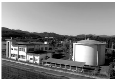
北東から見た水道庁舎
