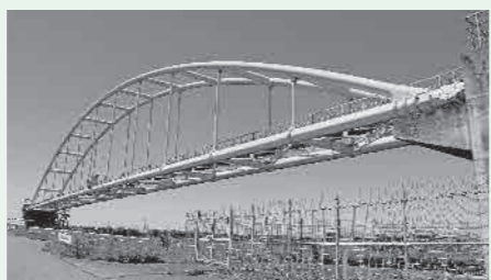
県水が流れる志戸川水管橋
