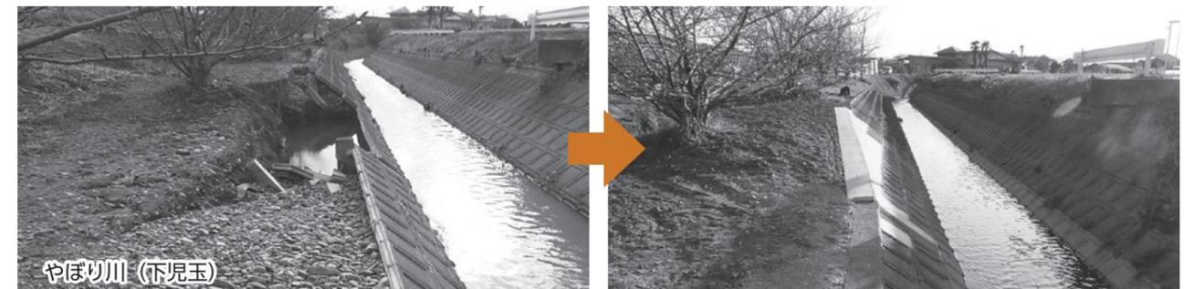
護岸ブロックが破損したことで、護岸裏等の土砂が流出した。そのため、護岸ブロックを復旧する工事を実施した。
