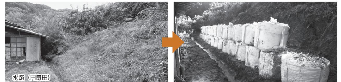
法面が崩壊し、土砂や草木が民地に流れ込み、水の流れを阻害した。そのため、土砂を撤去し、大型土のうを設置することで法面が再び崩壊しないよう復旧した。
