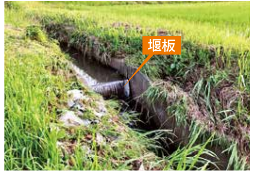
▲堰板が設置してある排水路
