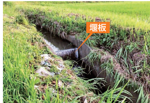
▲堰板が設置してある排水路
