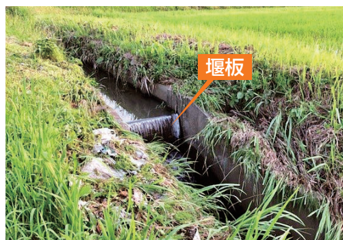
▲堰板が設置してある排水路
