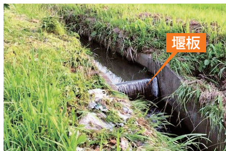
▲堰板が設置してある排水路
