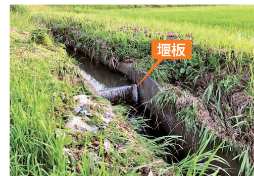
▲堰板が設置してある排水路
