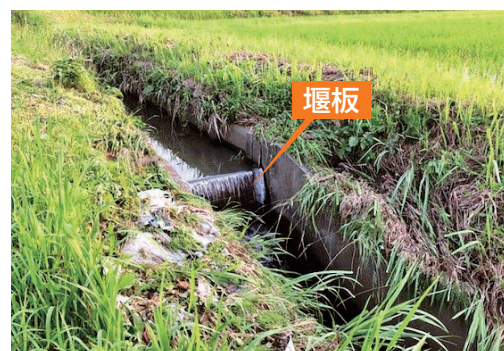
▲堰板が設置してある排水路
