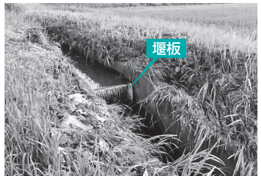
▲堰板が設置してある排水路
